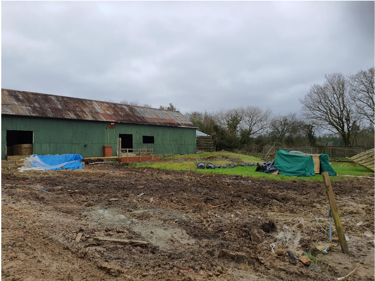
SW Elevation - 20210119_144651.jpg
