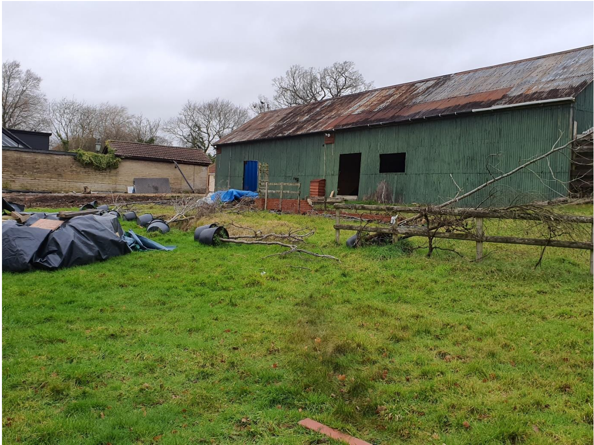
SW Elevation - 20210119_144833.jpg
