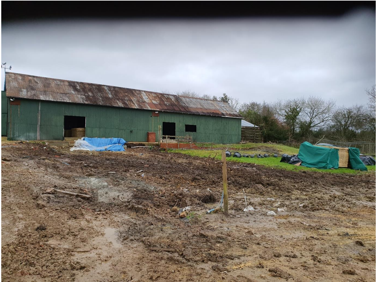
SW Elevation - 20210119_144705.jpg
